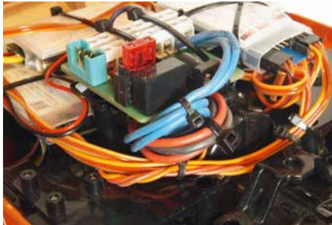
Auch im Testaufbau muss Ordnung sein; für einen endgültigen Aufbau sollte man die Leitungen so weit wie es geht einkürzen. Über den grünen Multiplex-Stecker wird der Akku angeschlossen
