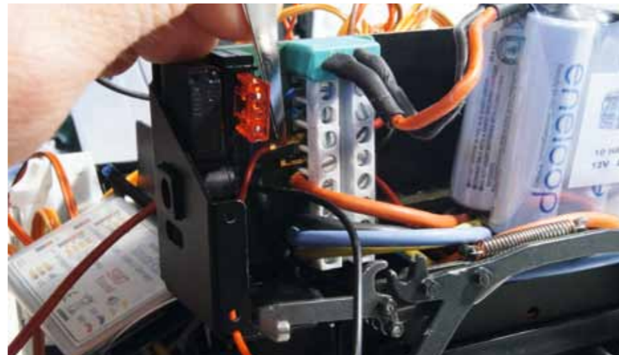
Die Elektroverteilung im ScaleART-Actros bietet noch freie Schnittstellen, um die Spannungsversorgung des SM7 sicherzustellen
